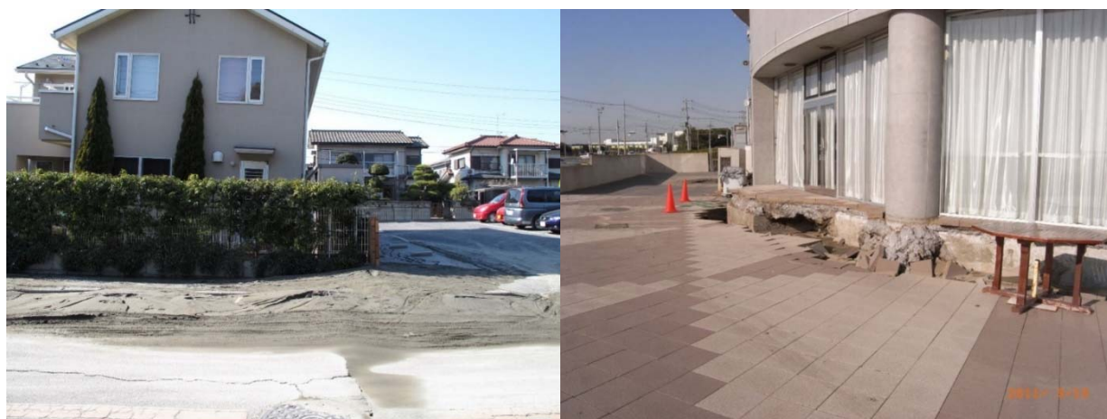
写真 液状化地盤における住宅や建築物の被害(千葉大・中井名誉教授提供)
