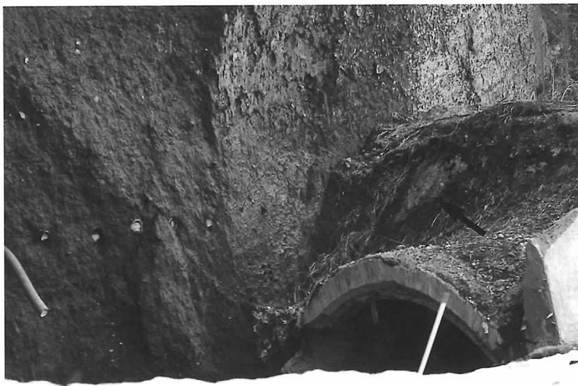
Fig. 5 豊浜トンネル覆道部に見られるくびれ（矢印）
