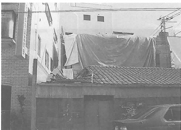
写真9. 呉市本町、死者が発生した建物
