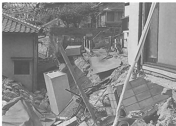
写真 5. 呉市江原町の宅地の崩壊、東側より
