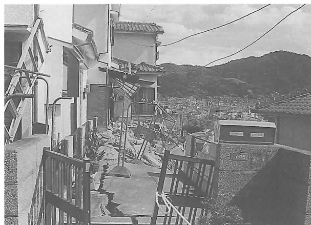
写真 6. 呉市江原町の宅地の崩壊、西側より
