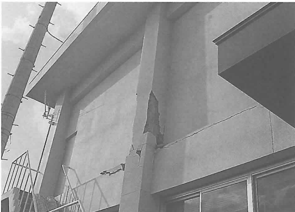
写真21. 沖美町役場、中柱の破壊
