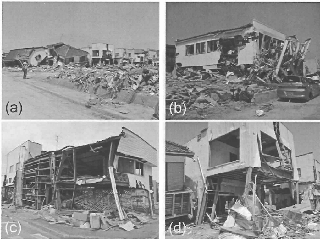
写真 4.3.12 小規模建築物の被害：(a) 倒壊した家屋群、(b) 倒壊した S 造建築物、(c) 大きく変形した S 造建築物、(d) 初層に大変形を生じた S 造建築物。
