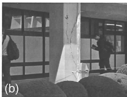
写真 3.2.3 大学校舎 C: (a) 外観、(b) せん断破壊した 1 階柱。
