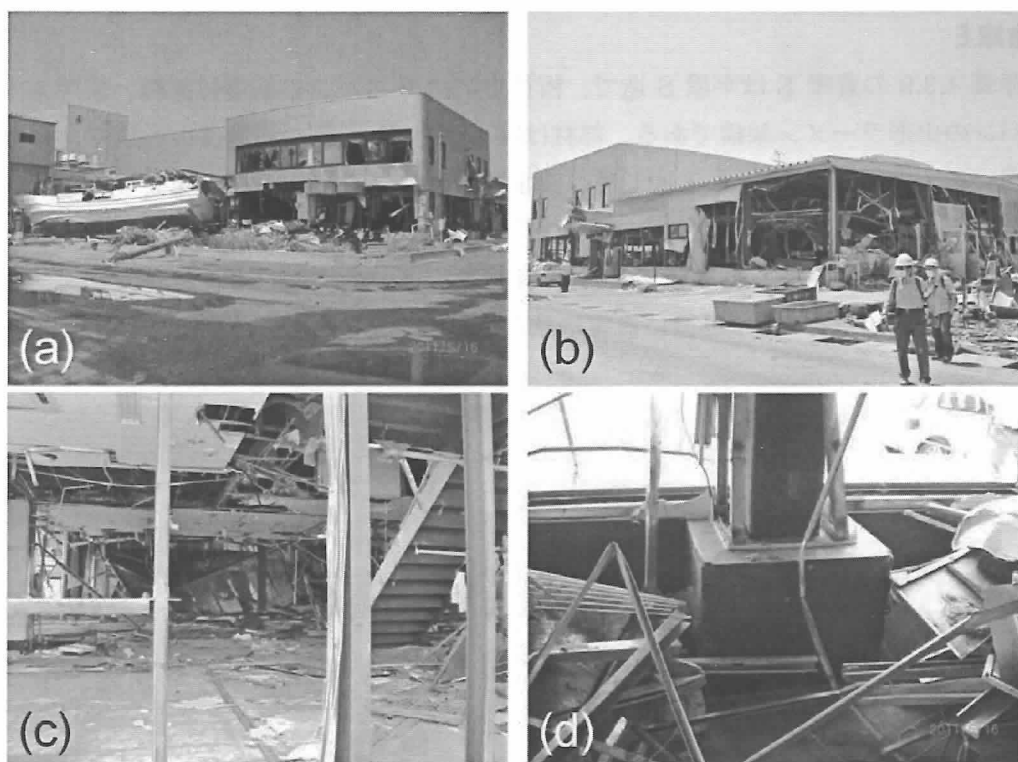
写真 4.3.5 工場 C : (a) 海側の外観、(b) 山側の外観、(c) 内装材や天井材の損傷、(d) 損傷がみられない根巻柱脚.
