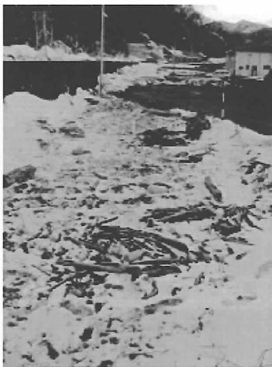
写真45 目黒漁港南部の遡上限界。積雪上の浮遊物(斜面上から)。
