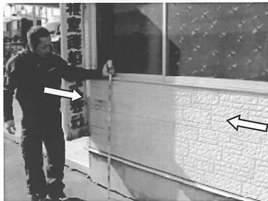
写真7 造船所事務所外壁の津波痕跡
