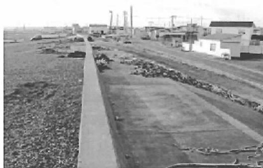
写真13 浜中町霧多布港市街南西側の防潮堤（北西方向）。この付近で水位が防潮堤の高さをわずかに上回った。
