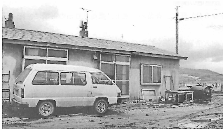
図 30：公営住宅の状況(1993. 11)
