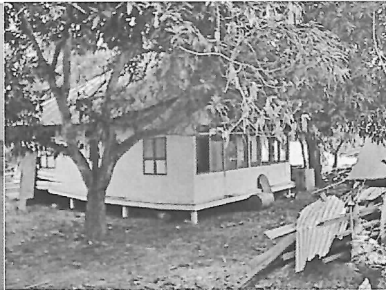
写真6：2005年2月調査で発見された、同市郊外の沿岸集落で流失を免れた住宅
