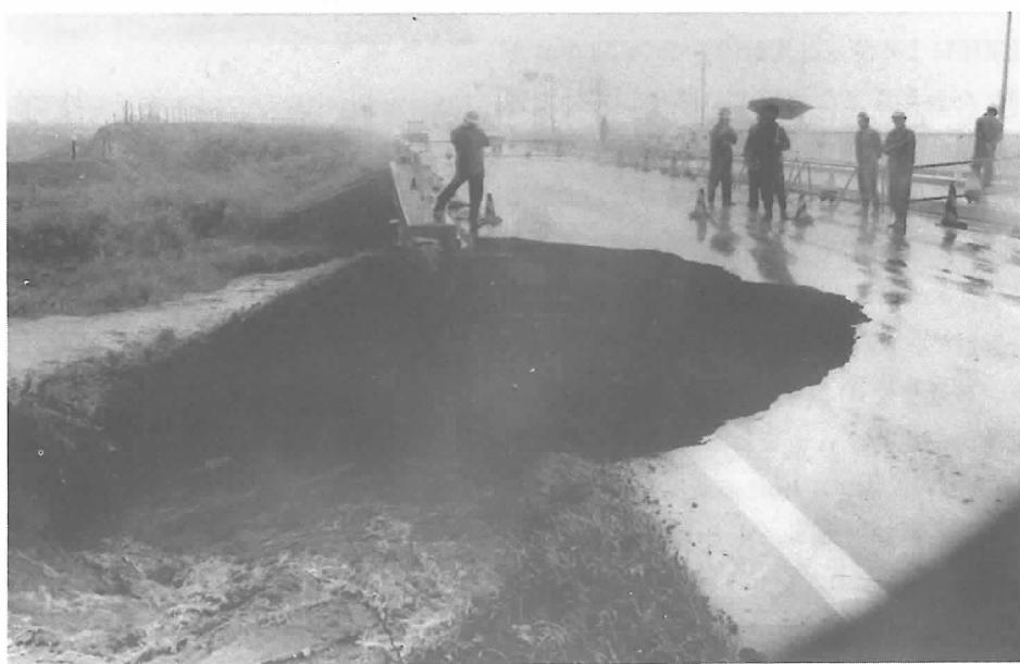
写真4. 水流でえぐり取られた国道36号線の樽前橋橋脚付近(8月26日、苫小牧市樽前)。
