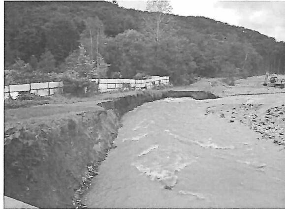
図4.19.2 左岸側堤体の浸食状況
