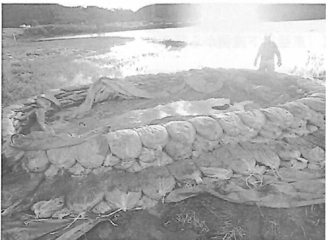
図 4. 5. 3 応急対策のかま段工法
