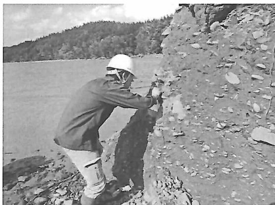
図 7. 8. 3 上流側決壊口（堤体の決壊口）
