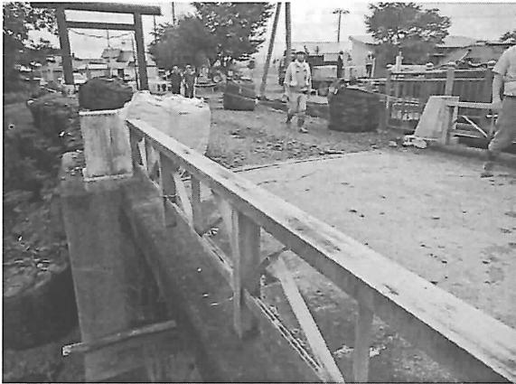
図4.19.1 右岸側橋台の応急復旧状況
