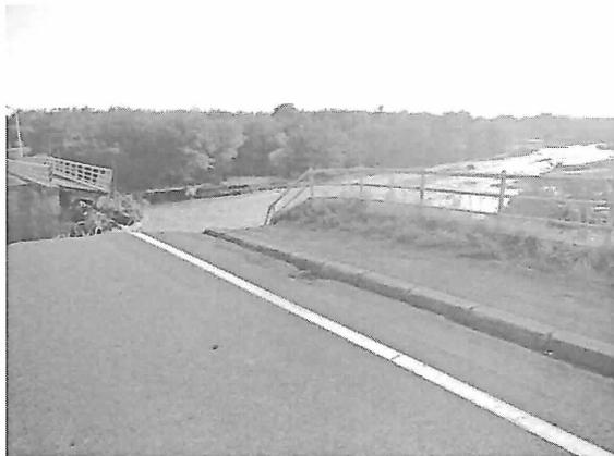
図 7.5.2 清見橋の被災状況（左岸から撮影），左岸橋台の背面土が流出し，道路の一部が流出。
