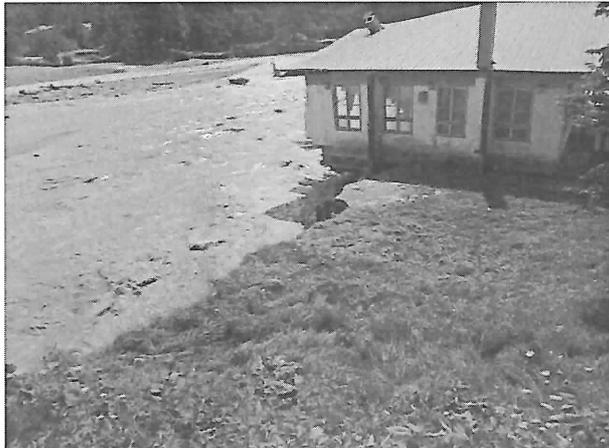
図 7.3.3 千呂露橋の周辺の河岸侵食状況，橋梁下流にある家屋の一部がオーバーハングしている。
