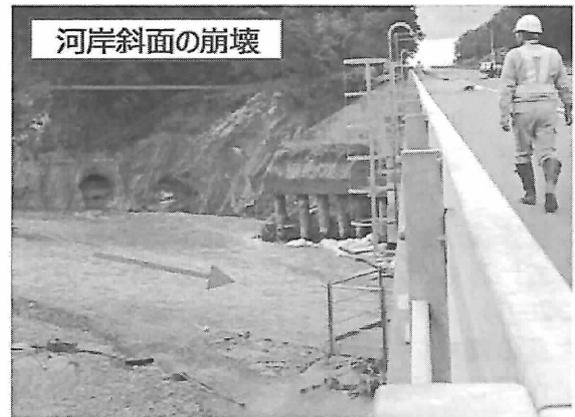
図4. 21. 2 左岸河岸斜面の崩壊状況
