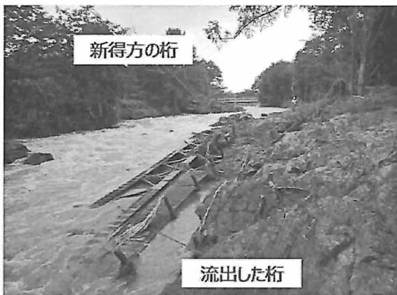
図4.20.1 流出した桁の状況
