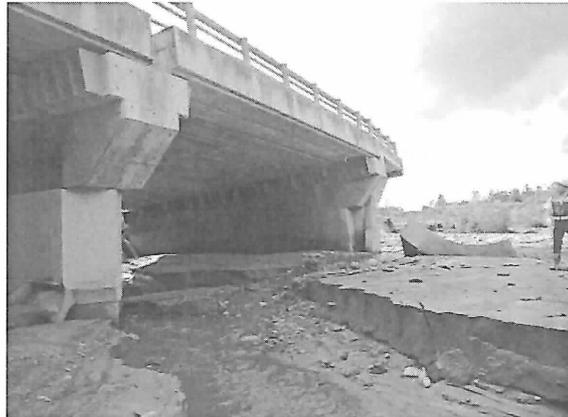
図 7. 4. 3 小林橋の被災状況(右岸から撮影), 上流側には流木が堆積.
