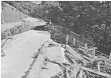
図 4. 11. 1 道路崩落箇所
