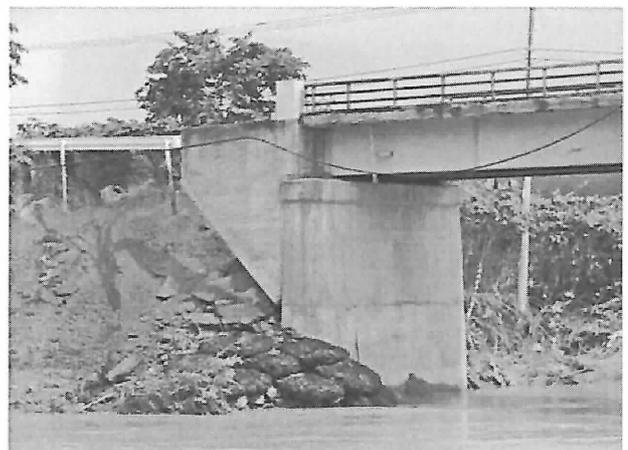
図4.8.2 橋台背面盛土の流出状況
