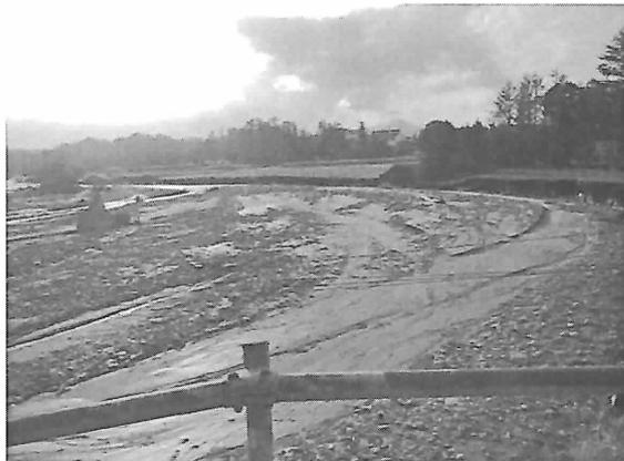
図 7.5.3 清見橋の被災状況（左岸から撮影），流木の堆積状況と上流側の河岸侵食状況
