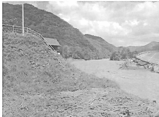
図 7.3.2 千呂露橋の被災状況(右岸から撮影)，河岸侵食により右岸橋台が沈下し主桁も落下。
