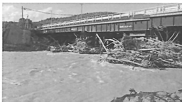
図 4.12.4 橋脚への流木の堆積状況
