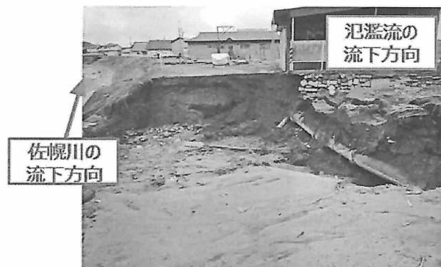
図4. 18. 4 氾濫流による佐幌川右岸護岸の浸食崩壊
