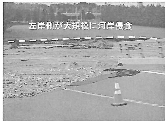
図 7. 4. 2 小林橋の被災状況(右岸から撮影), 河岸侵食により左岸橋台と左岸道路が流出.
