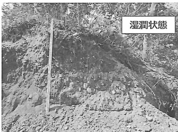
図4.16.3 上流方破堤断面の状況
