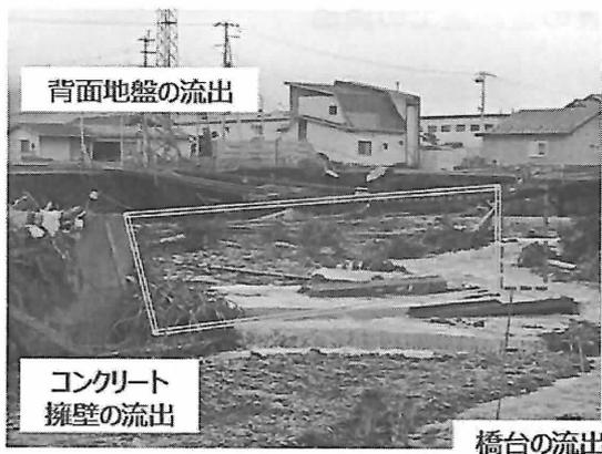
図4. 18. 3 橋台背面地盤の流出状況
