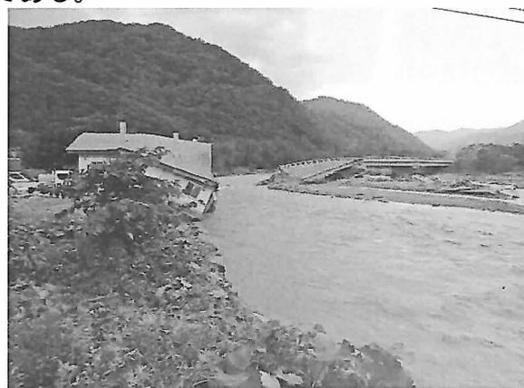
図 6.4.1 沙流川に架かる国道 274 号線の千呂露橋の被害状況
