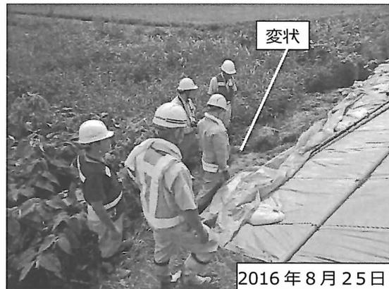
図 7.1.2 （左）網走川右岸堤防小段（光ケーブル埋設用の腹付け盛土）の法すべり （右）左写真箇所応急対策状況
