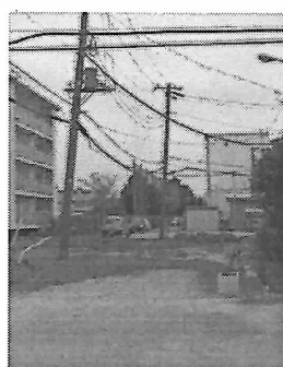
30cm程度堆積した噴砂と傾斜した電柱
