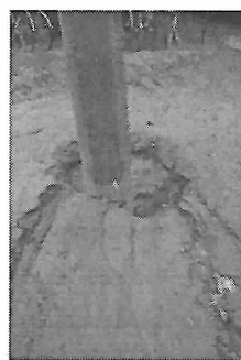
30cm程度堆積した噴砂と傾斜した電柱
