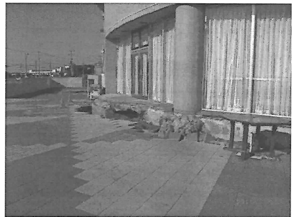
写真1 液状化地盤における住宅や建築物の被害（千葉大名誉教授・中井正一氏提供）
