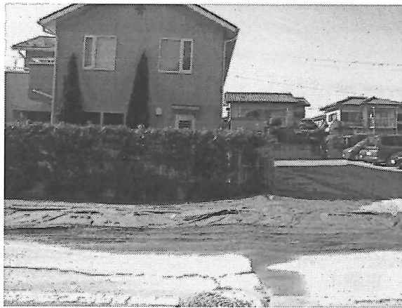
写真1 液状化地盤における住宅や建築物の被害（千葉大名誉教授・中井正一氏提供）
