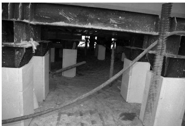
写真-6 西シベリアの高床式建物の床下構造:床下を冷気が通り抜けるようにしている（筆者撮影）
