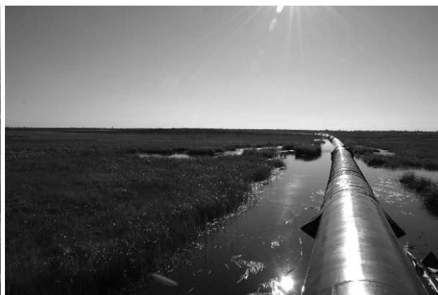
写真-11 パイプライン周辺土の融解が進んだ結果、水面上で浮遊状態に陥った西シベリアの天然ガス・パイプライン（筆者撮影）
