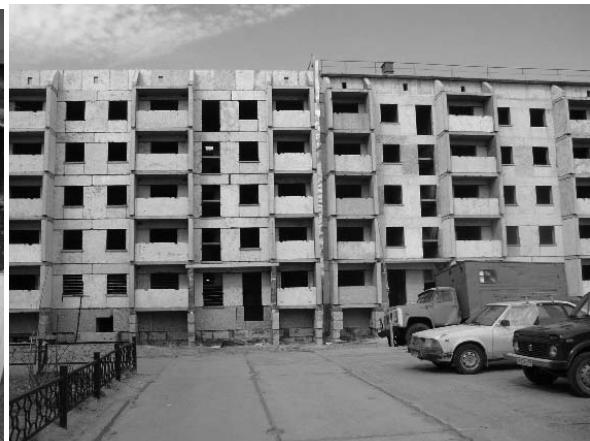
写真-7 西シベリアで建設途中に放棄されたアパート: 大きく傾斜している（筆者撮影）
