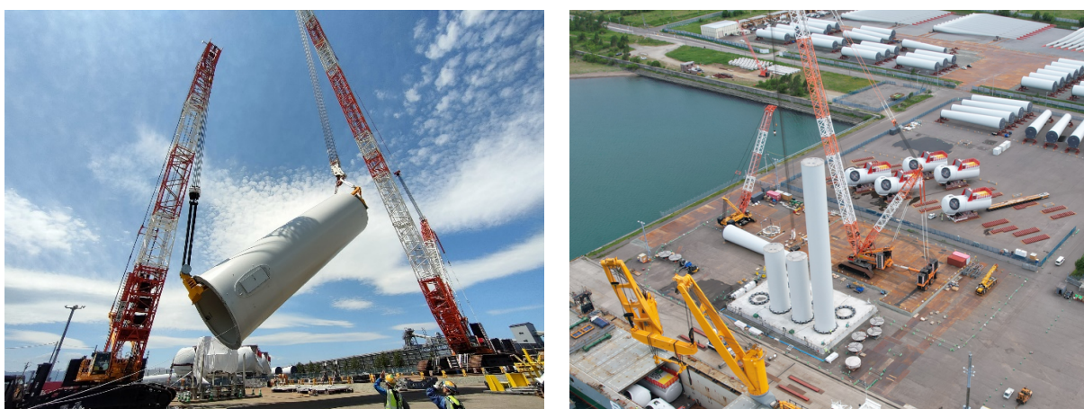
写真-8 風車タワープレアセンブル状況
