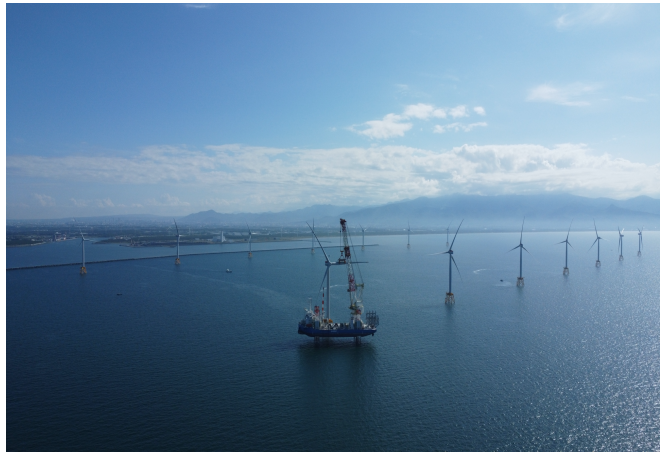
写真-10 風車据付け状況
