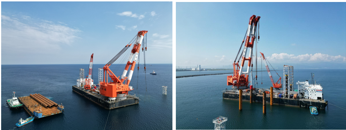
写真-4 杭施工状況
