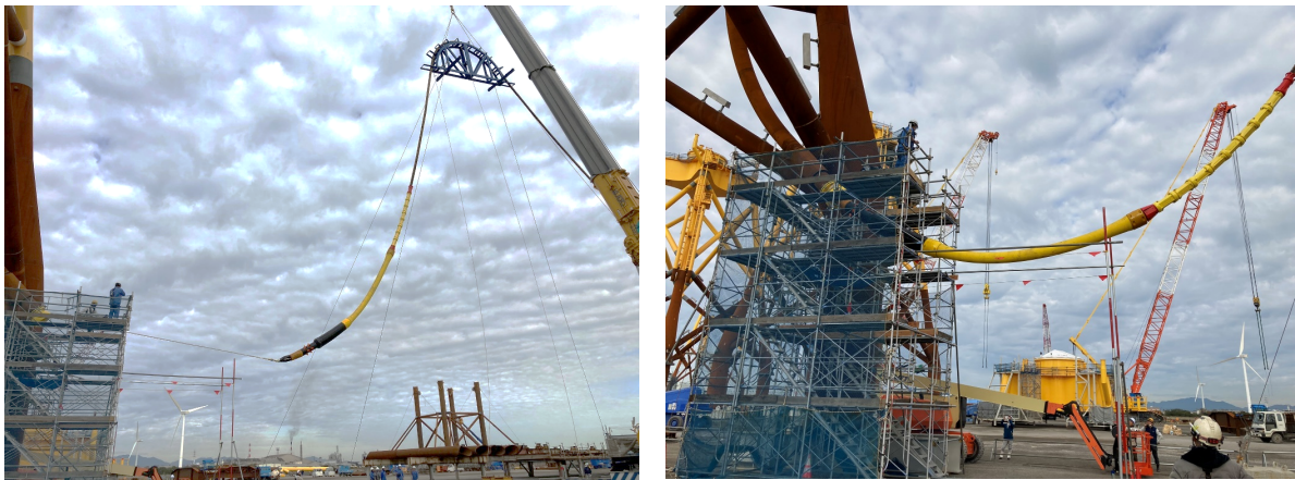
写真-7 ケーブル引込み試験状況
