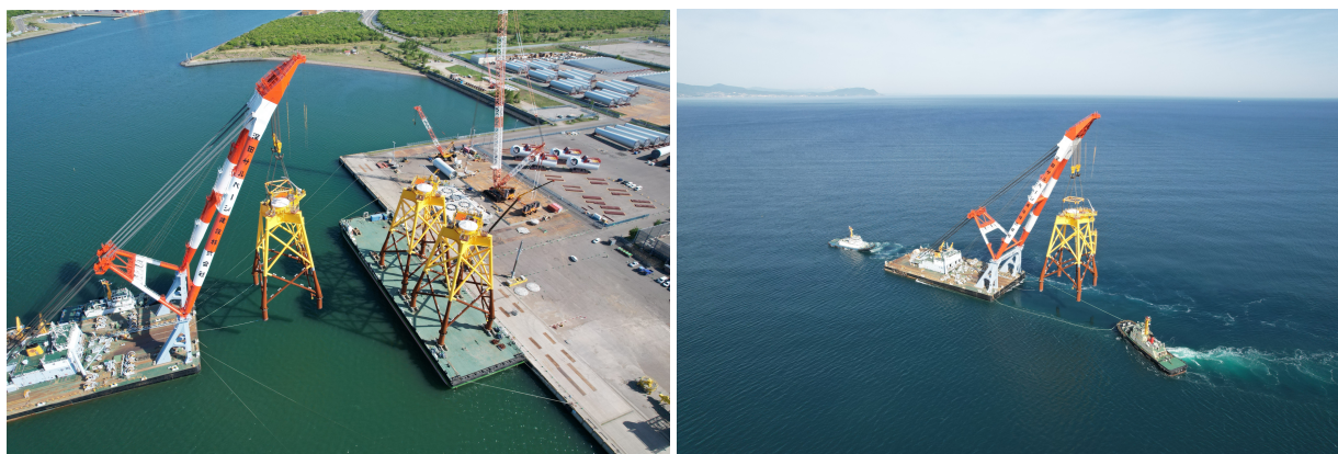
写真-5 ジャケット施工状況
