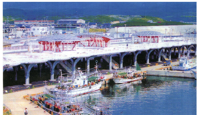
写真-6 青苗漁港の人工地盤 (提供：国土交通省北海道開発局)
