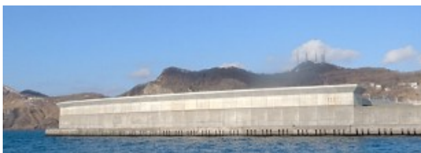
写真-3 波返工の設置状況 (提供：国土交通省北海道開発局)
