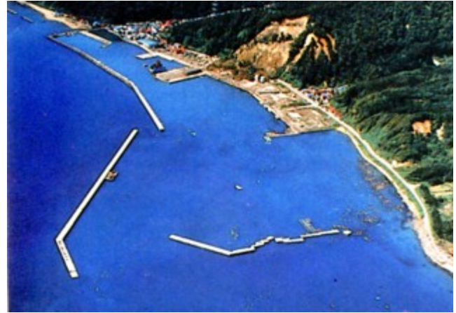
写真-5 奥尻港の防波堤被害 (提供：国土交通省北海道開発局)
