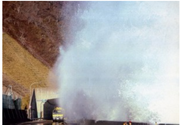
写真-7 国道 336 号荒磯海岸での越波状況 (提供：国土交通省北海道開発局)
