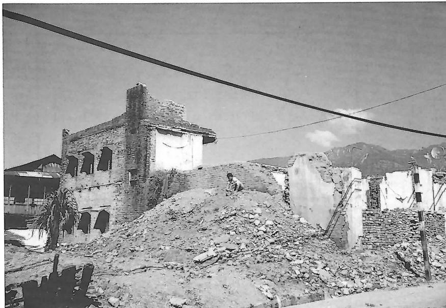
写真3 レンガ造3階建て住宅の全壊跡，ダランにて
