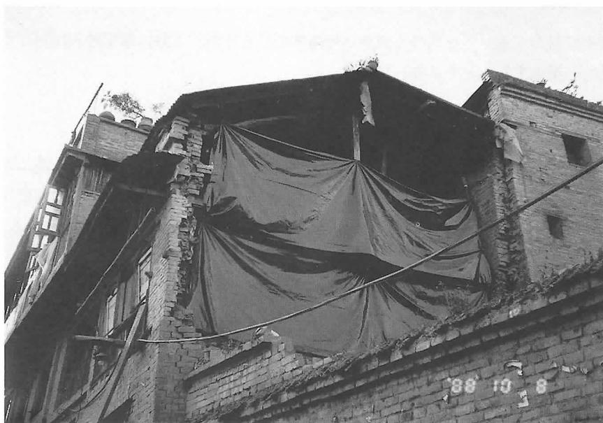
写真2 レンガ造2階建て住宅の妻壁崩壊，プラスチックシートは政府の支給品，バクタプルにて
